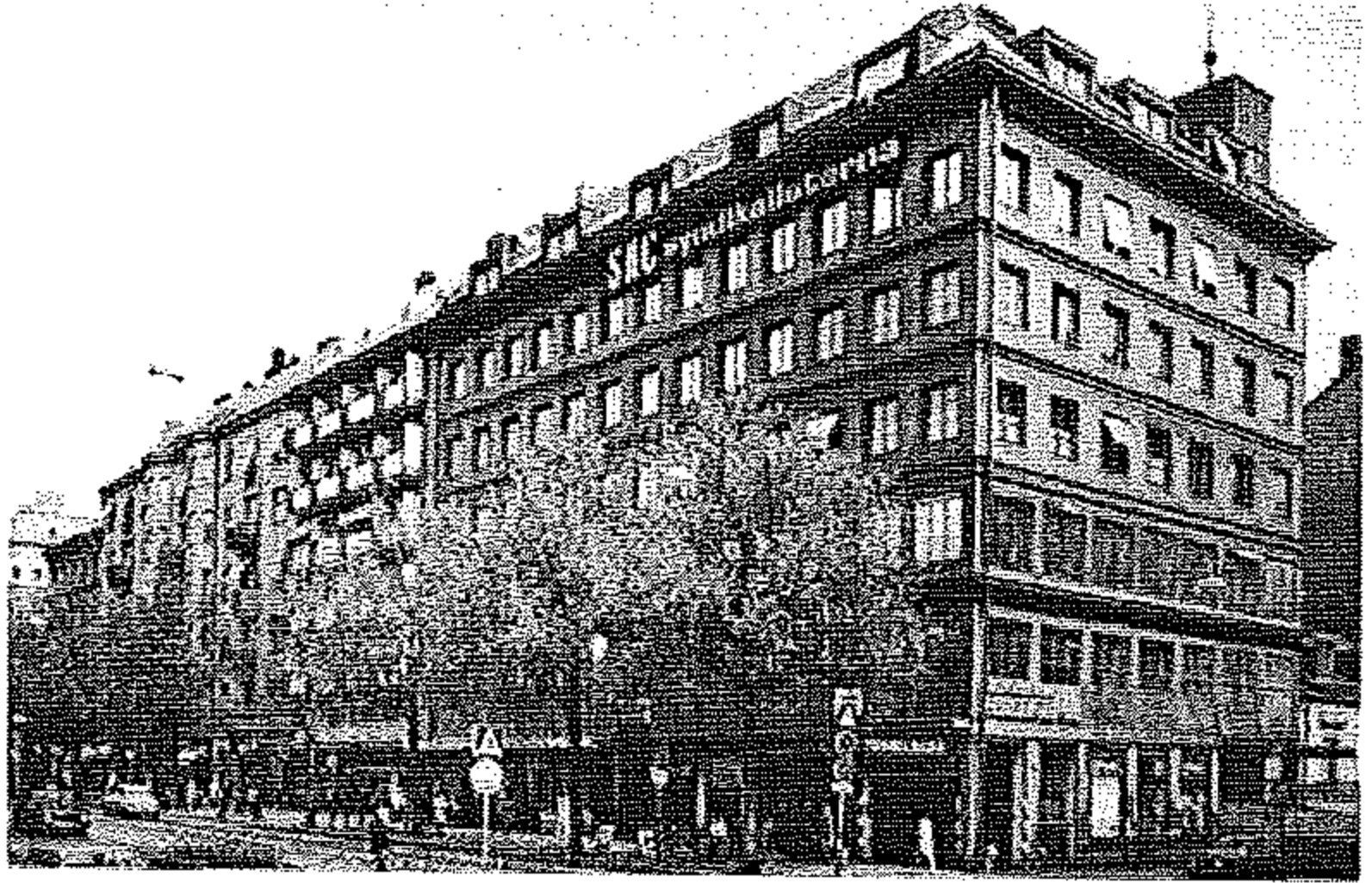
Kvartersfasad mot Sveavägen
